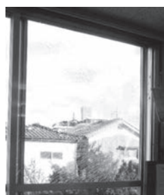
写真11 幼稚園窓合わせガラスの破損 (破損はしているが貫通・脱落はない)
