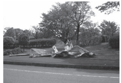
写真6 飛散した折板
