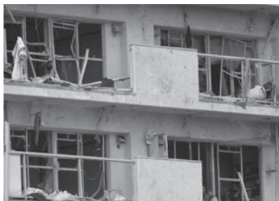
写真2 鉄筋コンクリート造 集合住宅
