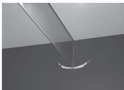
写真9 ガラス下部の移動
