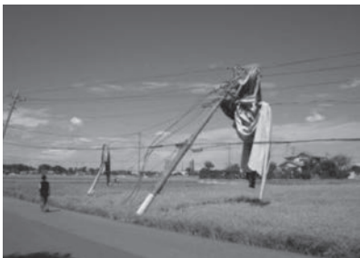
写真4 電柱の倒壊
