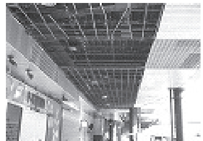
写真3 天井板落下
