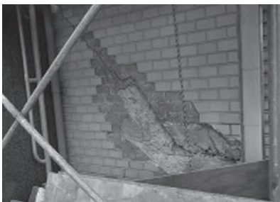
写真1 タイル剥落
